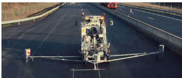
▲ Machine autoportée équipée des systèmes GNSS/RTK et Autopilot.
