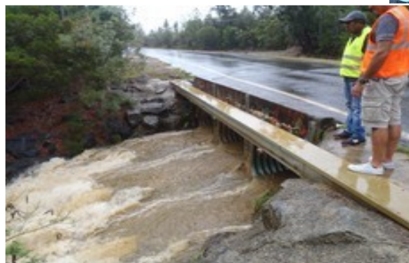
Illustration 7 : Expertise terrain DEPS / Cerema : identification des facteurs d'accident et des facteurs aggravants (Source : Cerema)
