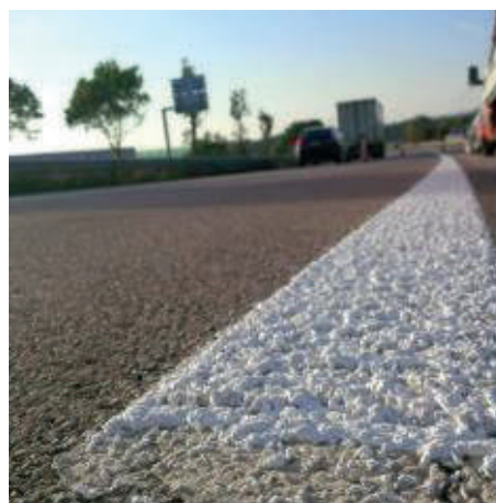
Figure 27 : Exemple de marquage VNTP en enduit à froid : crépi
