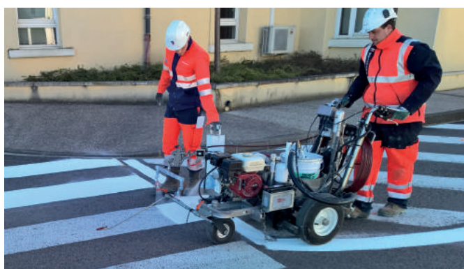
Figure 45 : Application par petite machine selon la technique traditionnelle
