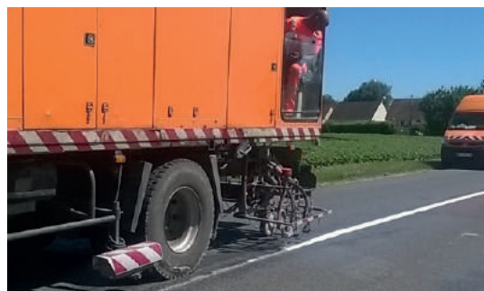
Figure 13 : Exemple d'application d'enduits à chaud projetés
