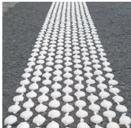
Figure 25 : Exemple de marquage VNTP en enduit à chaud
