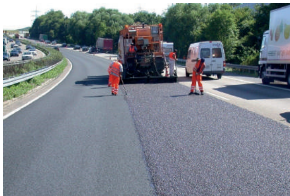
Figure 30 : Application de produits bitumineux
