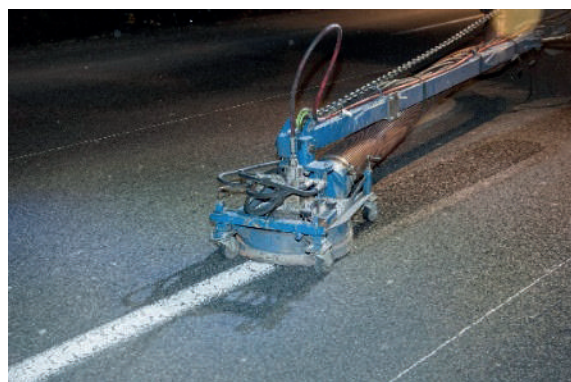
Figure 56 : Effacement d'un marquage par projection d'eau à haute pression
