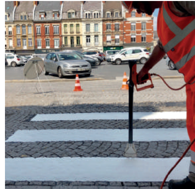
Figure 49 : Application de bandes préfabriquées thermocollées
