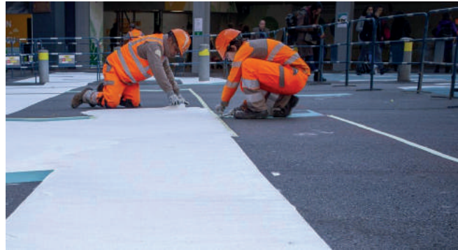
Figure 14 : Application d'enduits à froid
