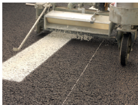
Figure 43 : Application d'enduit à froid en spot ou crépis
