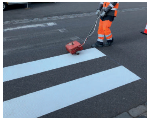
Figure 50 : Application de bandes préfabriquées collées à froid
