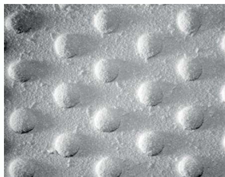
Figure 26 : Exemple de marquage VNTP en enduit à froid : spot
