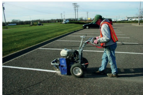
Figure 55 : Ponçage d'un marquage
