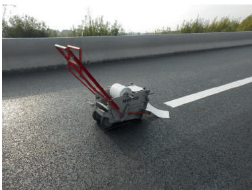
Figure 44 : Application de bandes préfabriquées collées par la technique dite over lay
