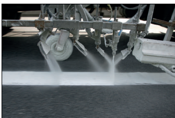
Figure 36 : Application selon la technique d'injection/saupoudrage
