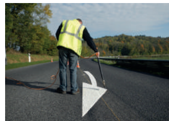
Figure 17 : Illustration de bandes collées à chaud
