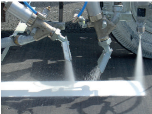
Figure 34 : Exemple d'application selon la technique du double saupoudrage
