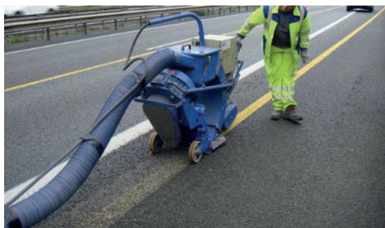
Figure 54 : Grenailage d'un marquage
