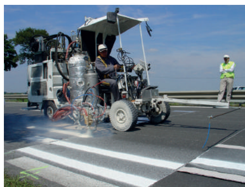
Figure 3 : Mise en place de nouveaux produits candidats à la certification sur la RN 2 provisoirement déviée à la circulation.
