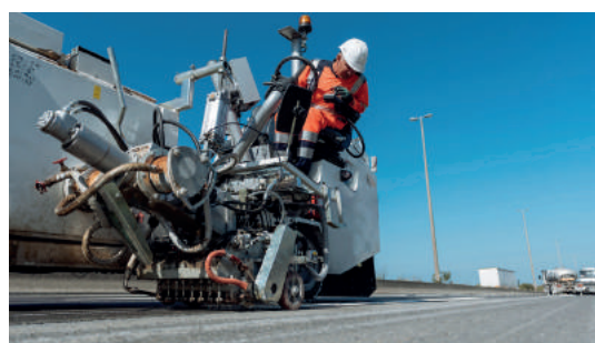
Figure 12 : Exemple d'application d'enduits à chaud en rideaux
