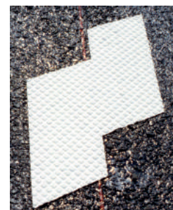
Figure 16 : Illustration d'une bande collée à froid
