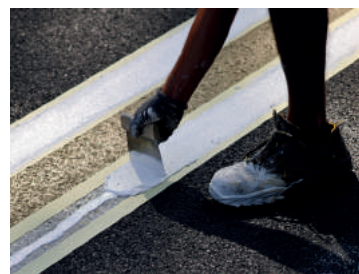
Figure 47 : Application manuelle d'enduit à froid
