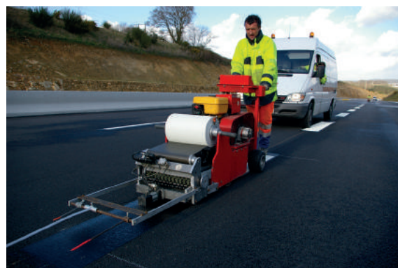
Figure 44 : Application de bandes préfabriquées collées par la technique dite over lay
