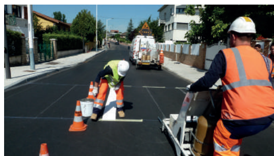
Figure 11 : Illustration de l'application d'enduits à chaud extrudés
