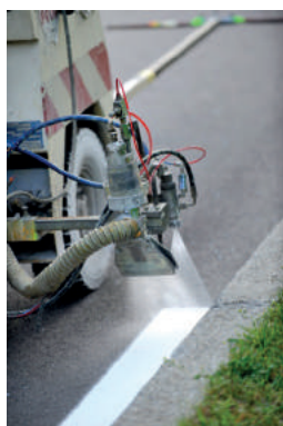
Figure 32 : Exemple d'application selon la technique dite de saupoudrage
