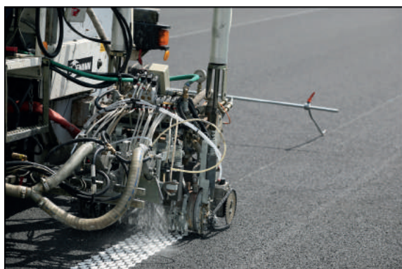
Figure 40 : Application d'enduit à chaud selon la technique du rideau
