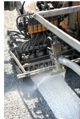
Figure 38 : Application d'enduit à chaud selon la technique extrudée
