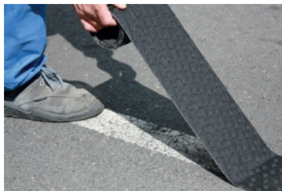
Figure 57 : Application d'une bande de masquage
