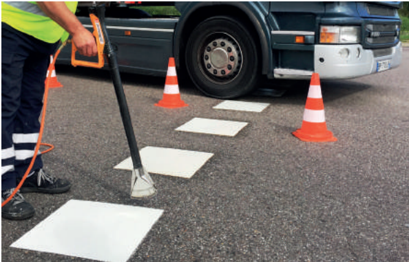
Figure 49 : Application de bandes préfabriquées thermocollées
