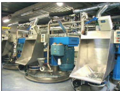
Figure 5 : Ajout des matières premières dans le mélangeur
