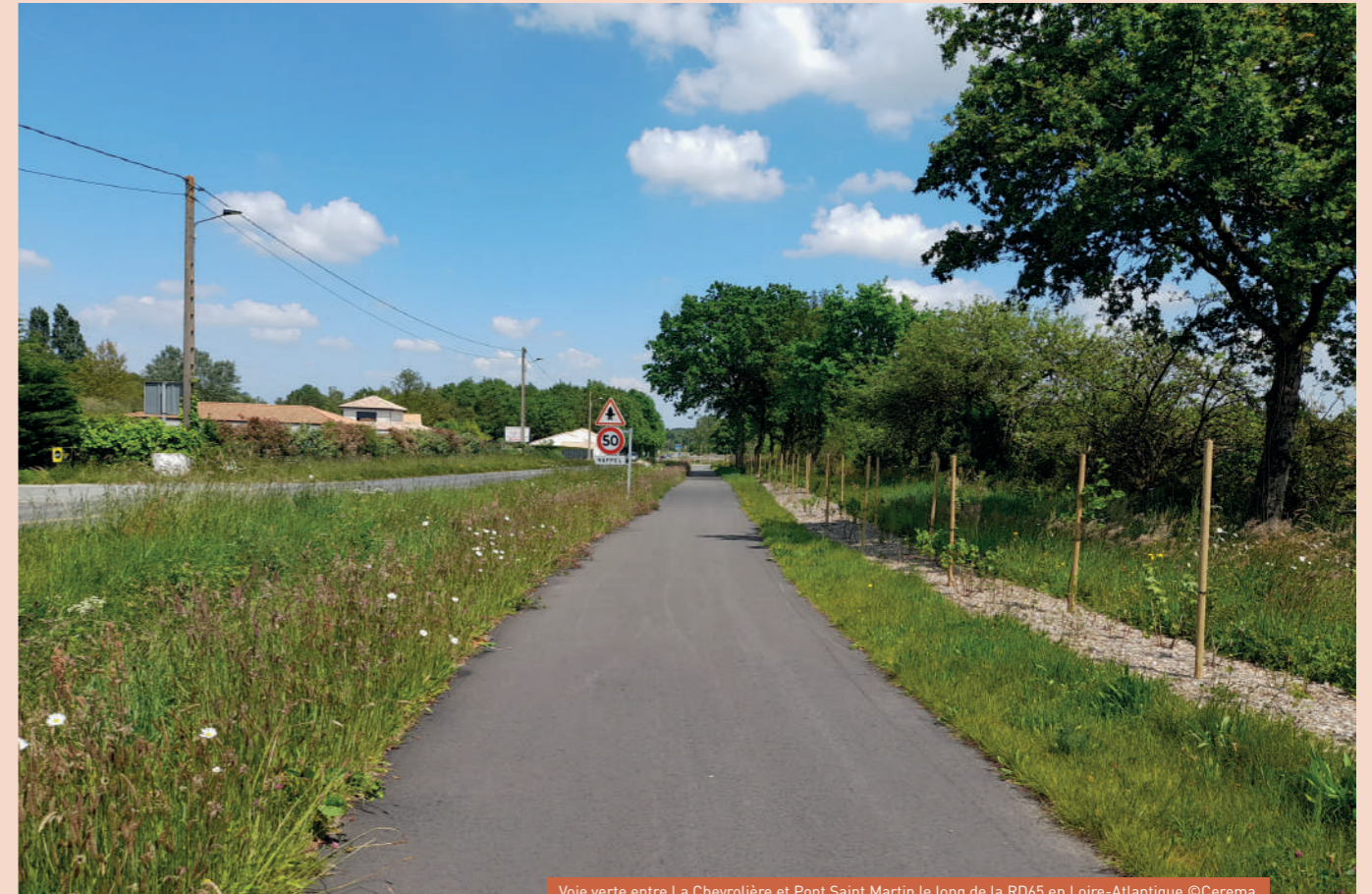
Voie verte entre La Chevrolière et Pont Saint Martin le long de la RD65 en Loire-Atlantique ©Cerema
